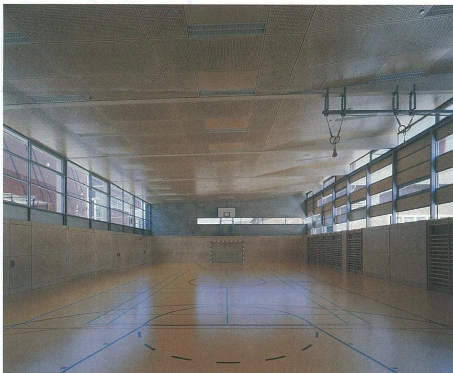
Die Turnhalle im hofseitigen Trakt des Neubaus ist um zwei Meter abgesenkt. Im unteren Bereich sind die Wände mit Sperrholz verkleidet, die großzügige Verglasung darüber lässt reichlich Tageslicht in den Raum. Unter dem flächenelastischen Kunststoffboden wurde eine Fußbodenheizung verlegt.
