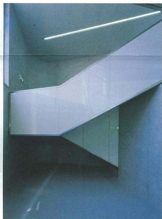
Sichtbeton kommt auch im Inneren des Eingangsbereichs zur Anwendung, wo eine Treppe Erd- und Untergeschoß verbindet. Der Boden ist als geschliffener Estrich mit Kunstharzspachtelung ausgeführt.
