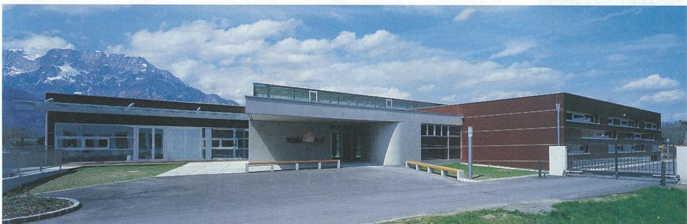
Der lang gestreckte, niedrige Baukörper des Neubaus bildet straßenseitig einen Abschluss des Geländes der landwirtschaftlichen Fachschule Winklhof. Es entsteht ein abgeschlossener, von Neubau und Bestand eingefasster Hof. Durch die Verwendung von Sichtbeton im Eingangsbereich und Untergeschoß und Max-Exterior-Fassadenplatten im Farbton Afro Maron im Erdgeschoß hebt sich das neue Gebäude, das Speisesaal, Küche und Turnhalle beherbergt, von den hellen Putzfassaden der anderen Schulhäuser ab.
