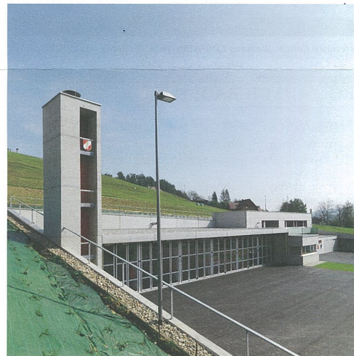
Der hoch aufragende Turm der Feuerwache ist auch für Übungszwecke nutzbar.
