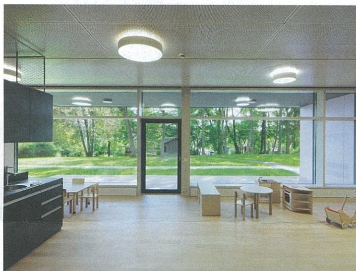
Das Vordach der verglasten Gruppenräume verhindert direkte Sonneneinstrahlung im Sommer.
